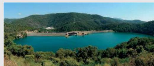
La retenue du lac de Saint-Cassien est formée par une dérivation des eaux de la Siagne et par la rivière le Biançon. Le barrage est en remblai à noyau central étanche et est associé à un évacuateur de crue et une digue fusible. Ce dispositif est conçu pour que le barrage supporte une crue décennale sans rupture.
